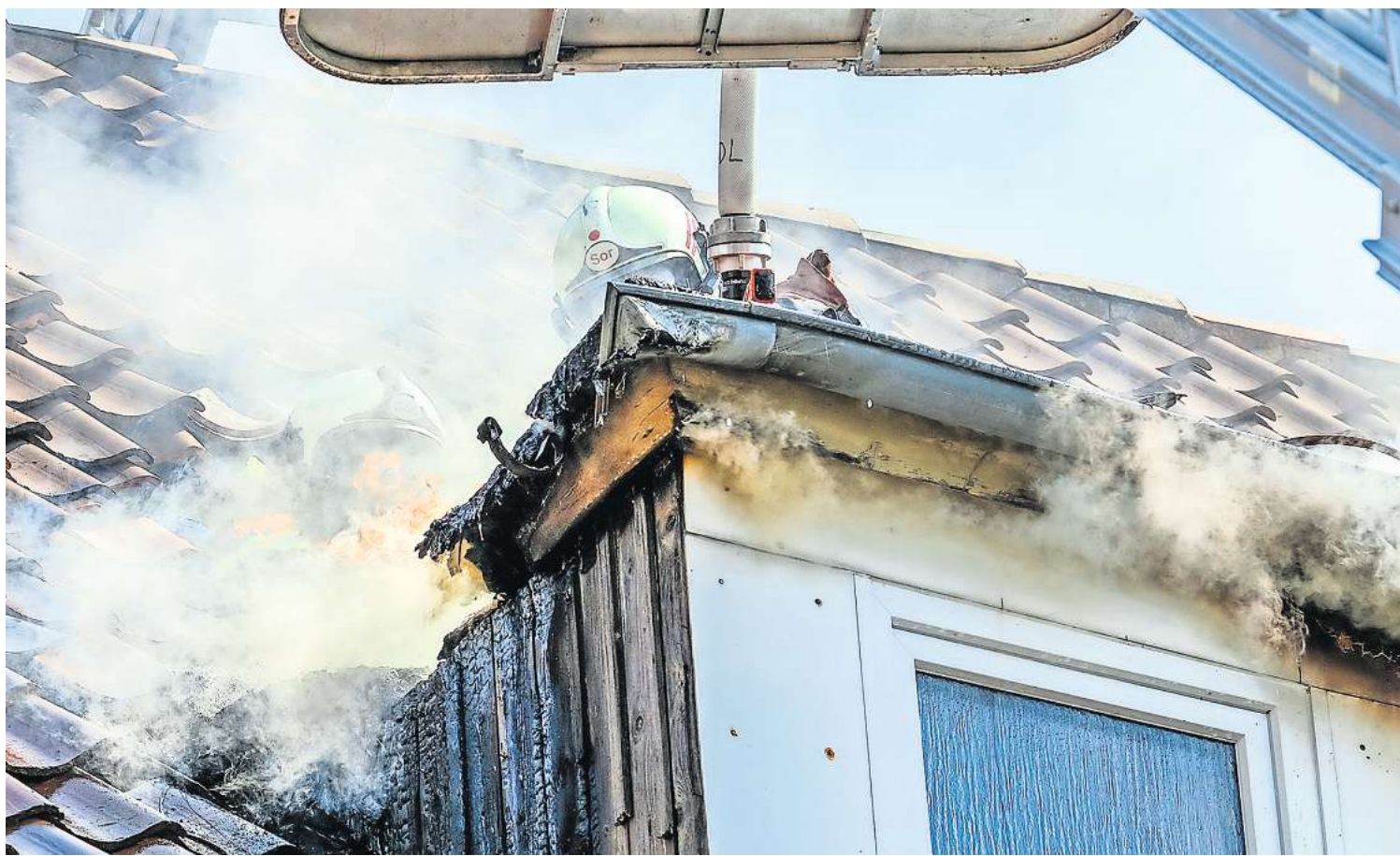
Wohnhausbrand in der Steuerwalder Straße: Immer wieder züngeln Flammen aus dem Gebälk des Dachstuhls.
